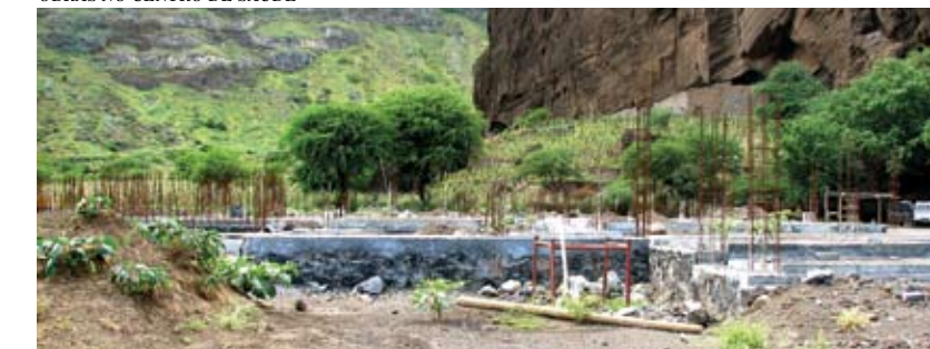
OBRAS NO CENTRO DE SAÚDE
